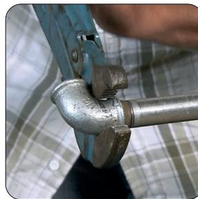
5 Fitting aufdrehen und mit Zange festdrehen. Der Hanf darf sich dabei nicht aus dem Gewinde herausdrehen. Überschüssiges Hanf entfernen.
