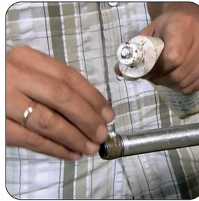
4 Ringsum einige Tropfen Neo-Fermit auf den Hanf auftragen. Dies erleichtert das Aufdrehen und verbessert die Dichtigkeit der Verbindung.
