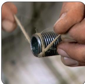
3 Ausreichende Menge Dichthanf rechtsherum vom Rohranfang hin zur Rohrmitte in die Rillen des Gewindes aufdrehen. Es darf kein Hanf in das Rohr hineinragen.
